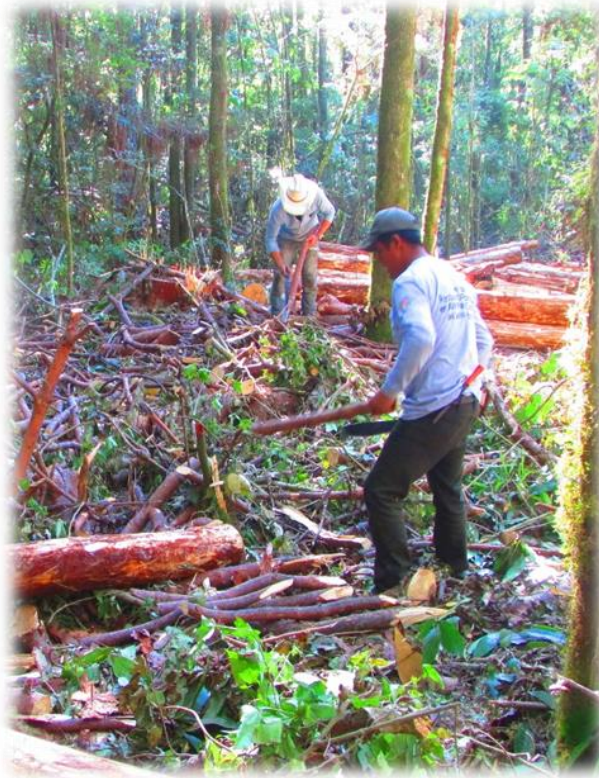
Figura 35. Corte de estacas para la construcción de cordones.
