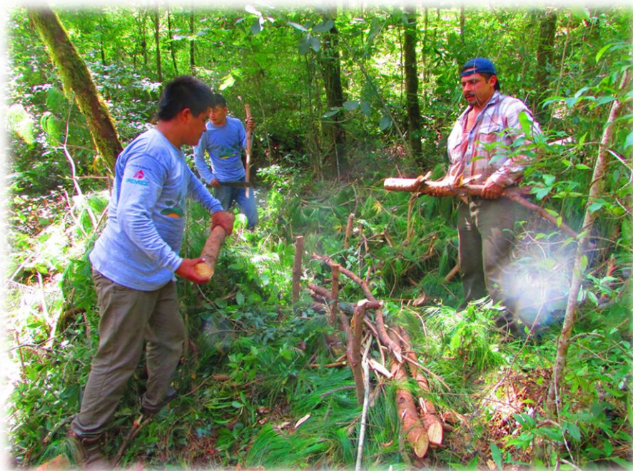
Figura 38. Construcción de cordones.
