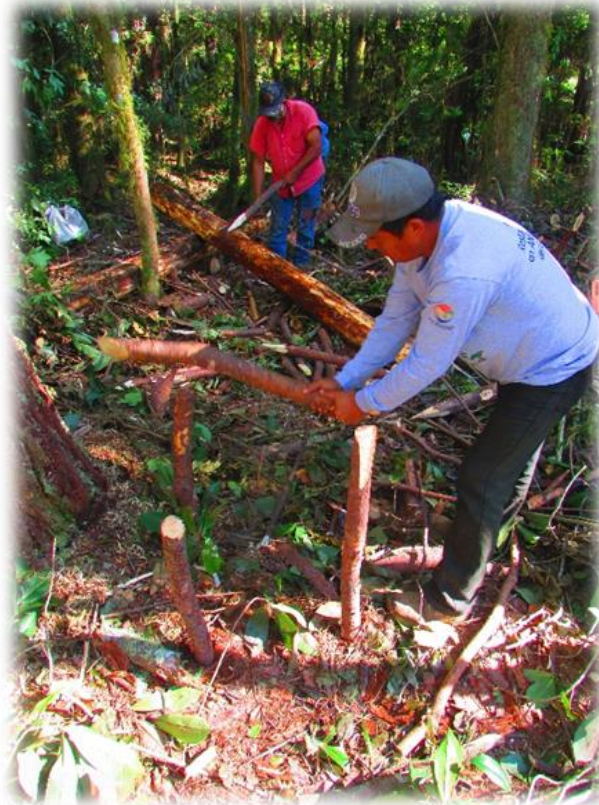
Figura 36. Colocación de estacas a tres bolillos.
